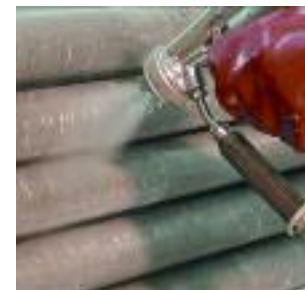
FIG. 9-10 Applicazione in cantiere su tubi alettati.
