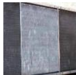
FIG. 14-15 Le due unità al termine del lavaggio a secco.
